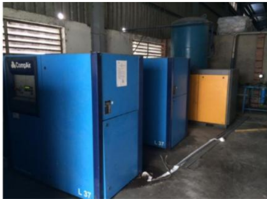
Hệ thống khí nén
