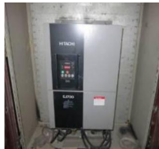
Biến tần lắp đặt cho máy nén khí
