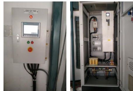
Hệ thống điều khiển trung tâm & biến tần
