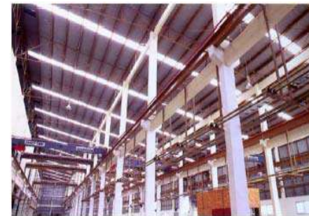
Các dải kính chạy suốt bề ngang của mái nhà theo các khoảng đều có thể cung cấp chiếu sáng tốt
