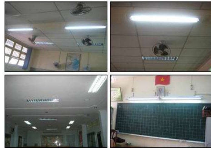
Đèn được bố trí hợp lý và được lắp chóa phản quang Thay thế bóng đèn dây tóc bằng bóng Huỳnh quang và có lắp chóa đèn phản quang
